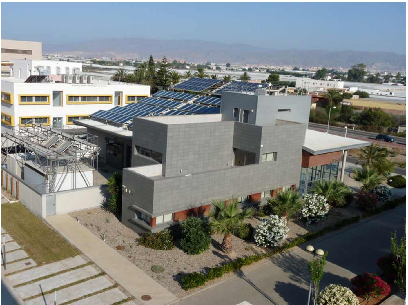
Equipos energéticos del edificio CIESOL.
